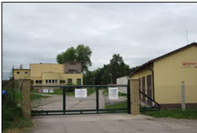
ÚPRAVNA VODY V RAKOVNÍKU
