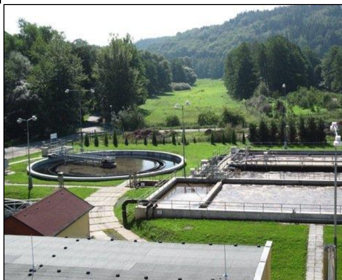
ČISTÍRNA ODPADNÍCH VOD V RAKOVNÍKU
